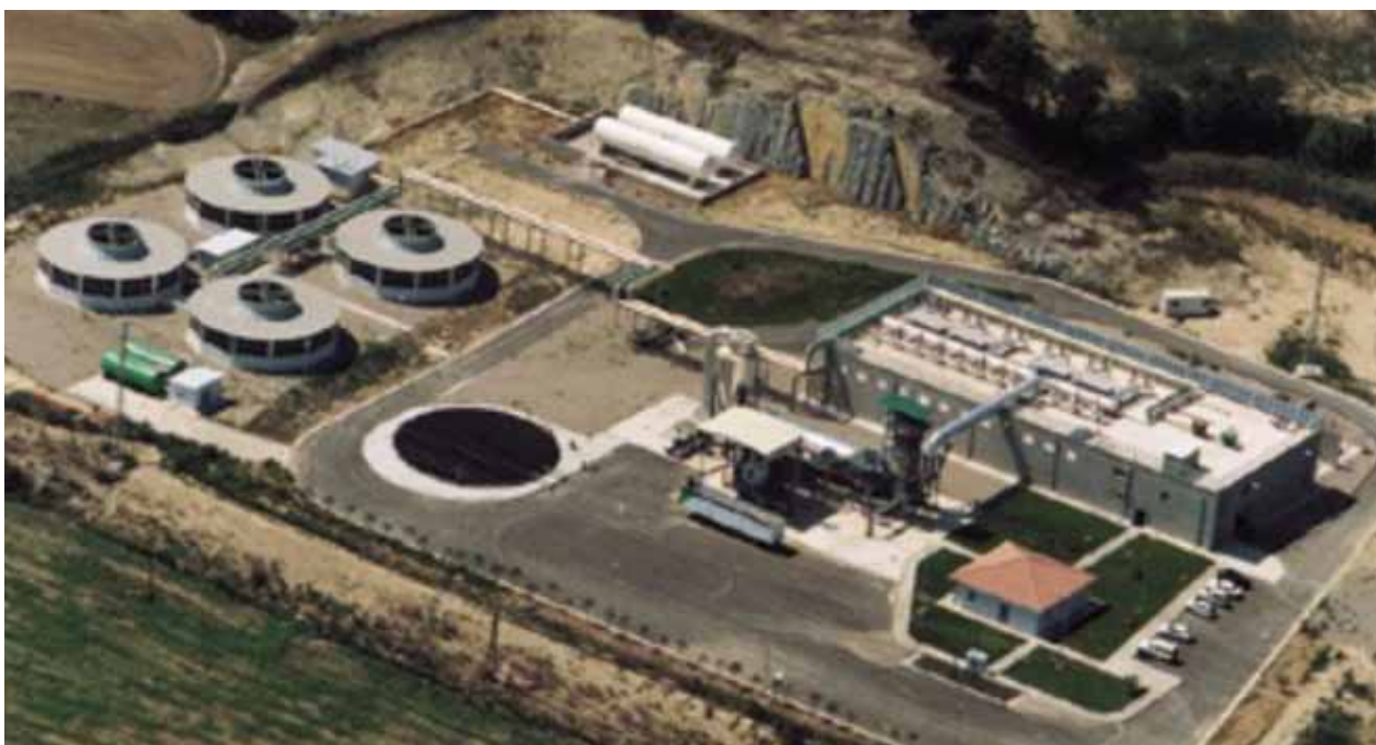
Figura 3. Planta de tratamiento y valorización de purines. Grupo Guascor.
